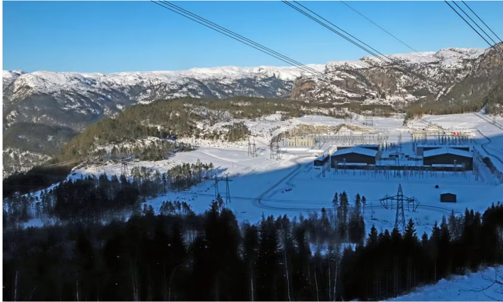
Statnetts likeretteranlegg på Ertsmyra ved Tonstad i Sirdal. Det går strømkabler til og fra Ertsmyra og Nederland og Tyskland, samt at det er et fordelingsanlegg for strøm mellom Agder og Rogaland her. Foto: Torbjørn Witzøe
